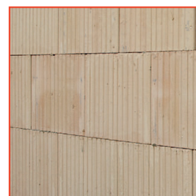
4. Sauberes und mass- genaues Mauerwerk
