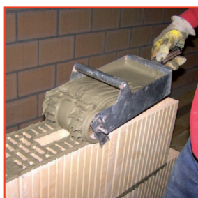
2. Auftragen Dünnbettmörtel
