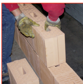
3. Versetzen EcoModul
