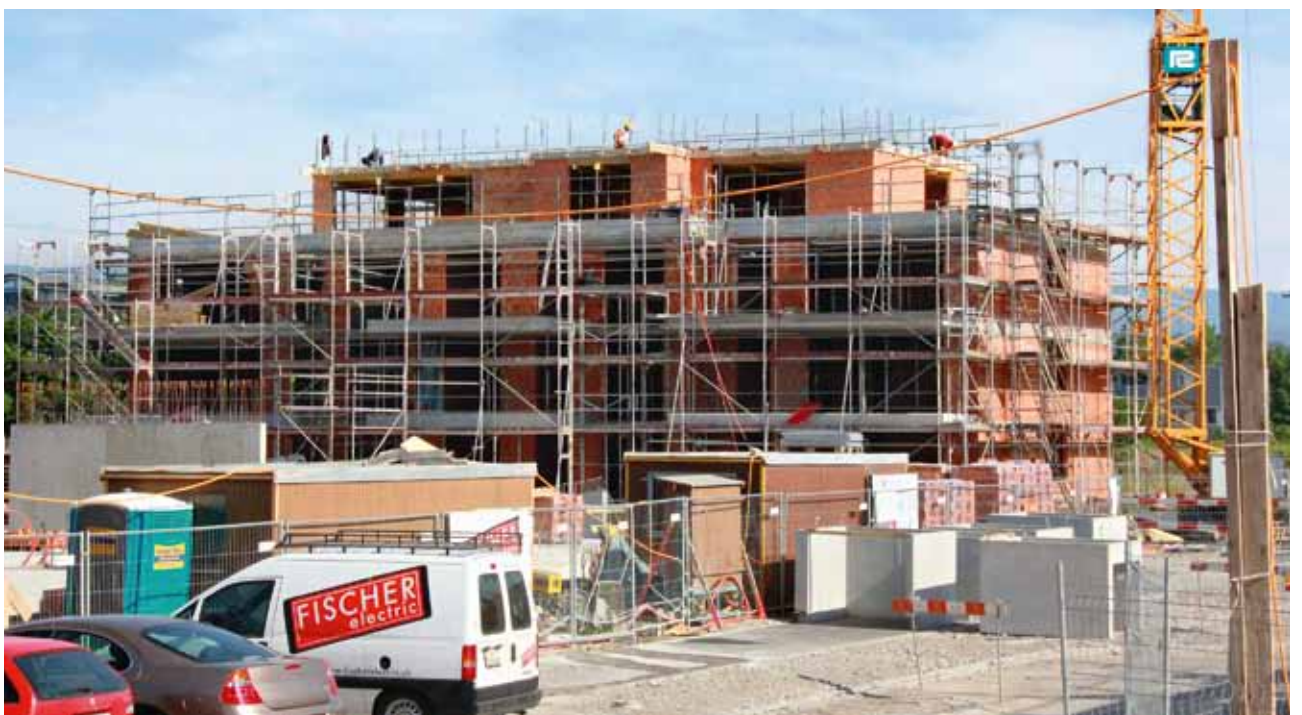
Rohbau im Mai 2015
